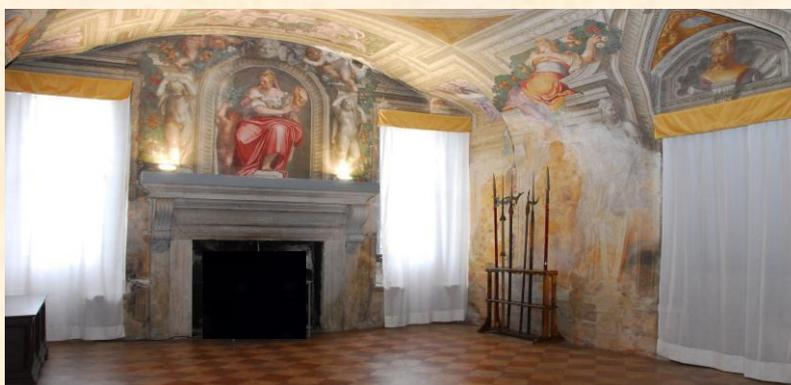
Der Saal wurde vermutlich von Zelotti in Zusammenarbeit mit Veronese ausgemalt. Die Fresken, Originale aus dem 16. Jahrhundert, sind im unteren Teil durch die aus den Bodenfliesen aufsteigende Feuchtigkeit stark beschädigt.
